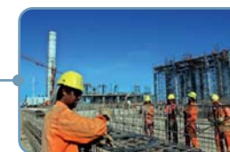
CONTROL DE OBRAS
